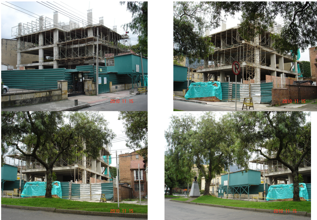
Estado actual de la obra, etapa de estructura
